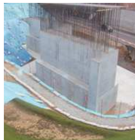
浜田三隅道路 跨道橋におけるコンクリート混和材 (エコパウダー)
