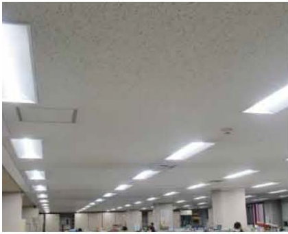
LED照明を利用したオフィス
