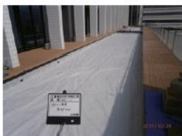
③透水シート敷設
