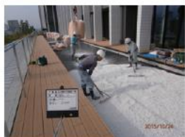
②スーパーソル敷設
