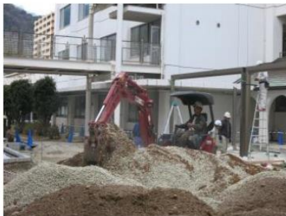
①スーパーソルを真砂土に混合
