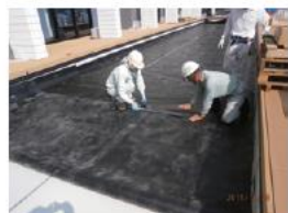
①防根シート敷設
