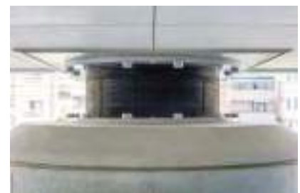
免震装置(柱頭免震構造)
