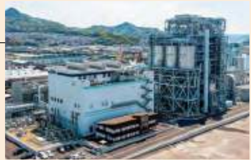
海田発電所(バイオマス発電)
