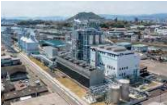
海田発電所(海田バイオマスパワー)
