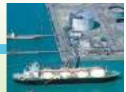
水島LNG基地 (水島エルエヌジー(株))
