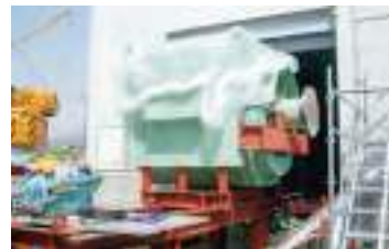
コージェネレーション改造工事
