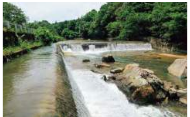
取水堰および導水路
